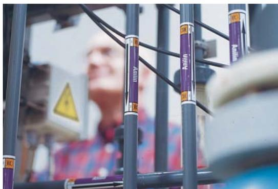
Маркеры рулонного формата для идентификации труб большого диаметра: свыше 70 мм : ПОЛОЖЕНИЕ 3
